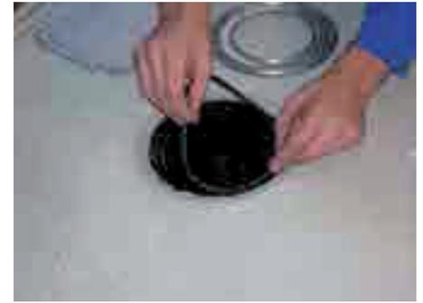
3. Bauschutz entfernen und Dichtflansch reinigen, Dichtung in die Ringnut des Dichtflansches einlegen
