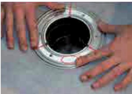
4. Dichtfolie über den Dichtflansch legen und Edelstahlring einpassen, Oberseite des Edelstahlringes beachten!
