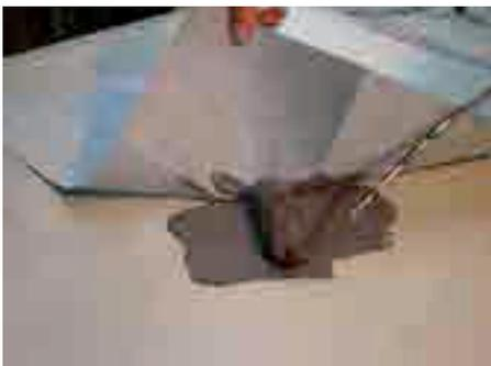
7. Verbundabdichtung vollflächig unter die Folie auftragen
